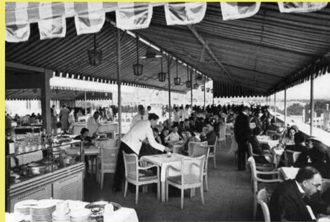
Dachterrasse mit Freiluftrestaurant, Gestaltung: Woldemar Brinkmann
